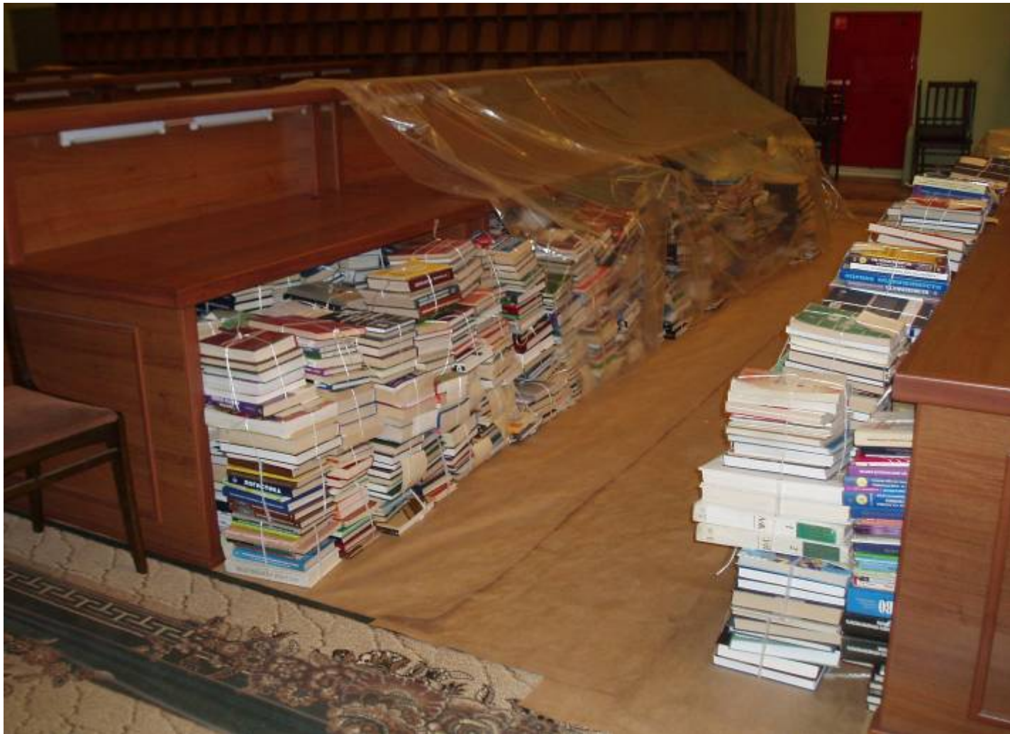
А так стало после ремонта
